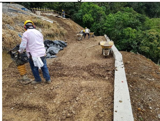
Foto Construcción Muro de Contención Acueducto Interveredal Argelia
