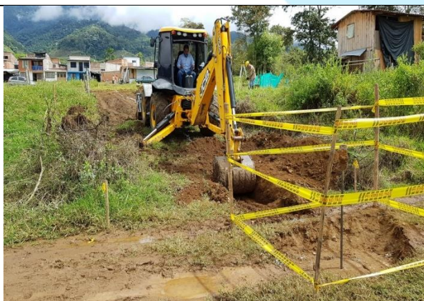
Excavación zanja
