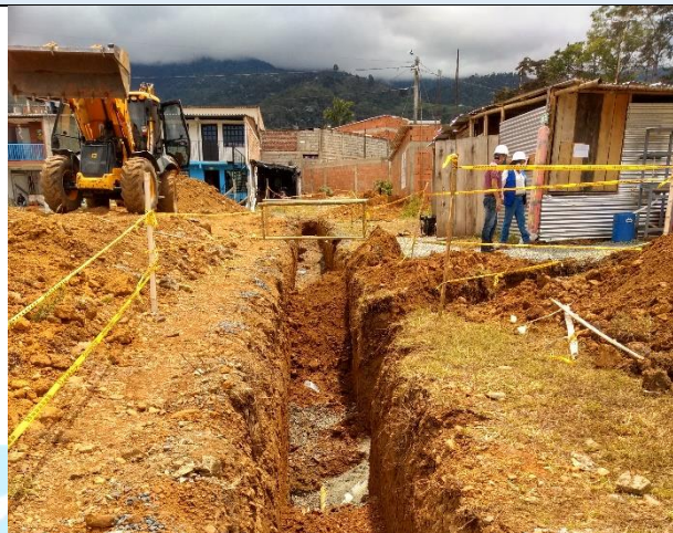
Vista a la obra 23 julio 2020
