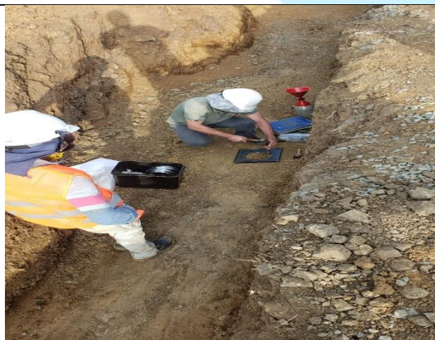
Ensayo densidades materiales relleno rocamuerta
