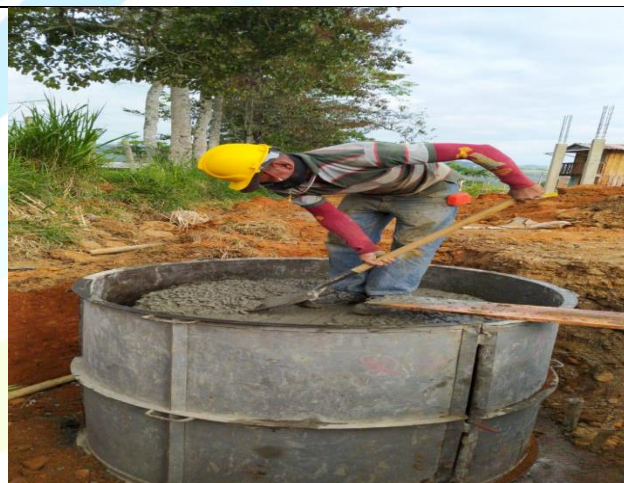
Fundición cámara
