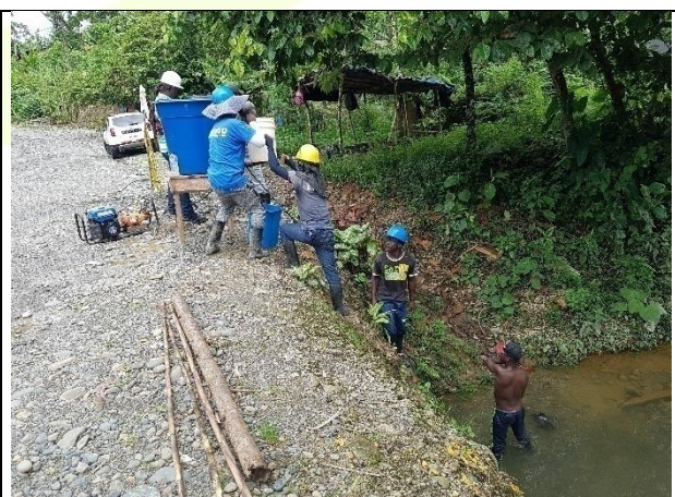
Lleno de tubería para prueba hidráulica
