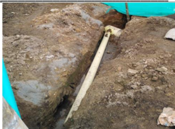
Insalcion tub. PVC san de 6" en acometidas
