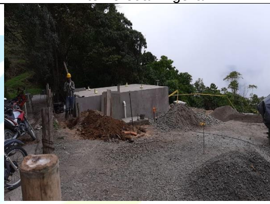
Foto Tanque de Almacenamiento Acueducto Interveredal Argelia
