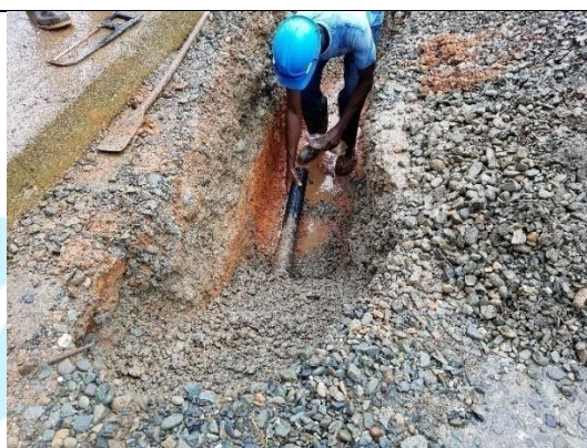
Instalación de tubería y relleno
