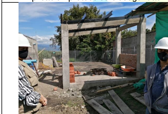
Caseta de bombeo
