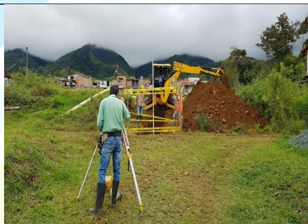
Control topografico nivel excavación
