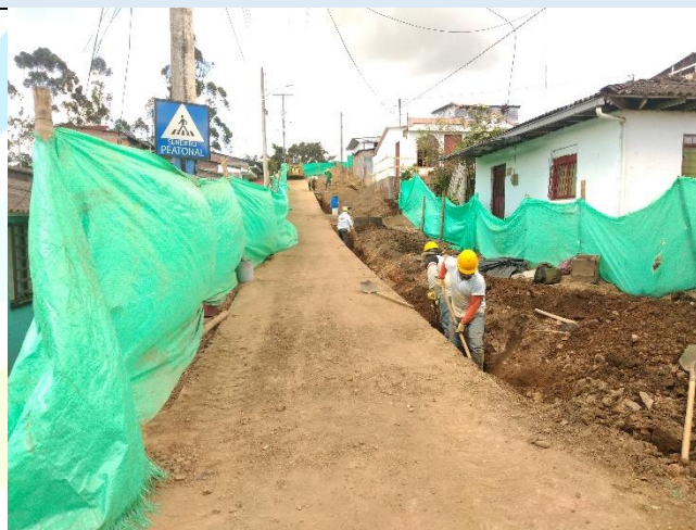
Vista a la obra 15 julio 2020
