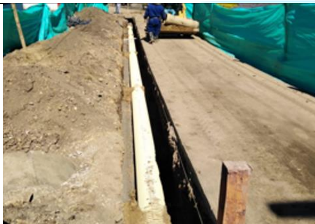
Instalacion de tuberia de 16" PVC sanitaria
