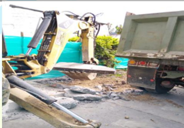
Cargue de escombros
