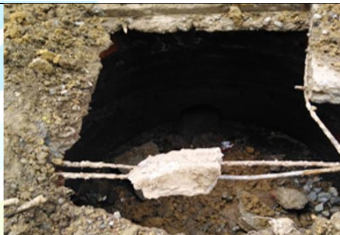
Demolicion de camaras
