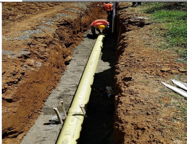
Instalación tubería novafort 8" sobre relleno
