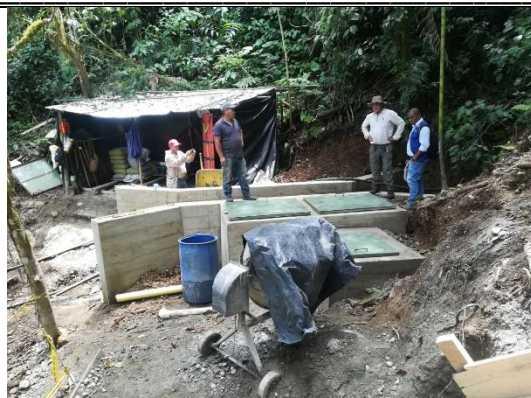
Foto Bocatoma Acueducto Interveredal Argelia
